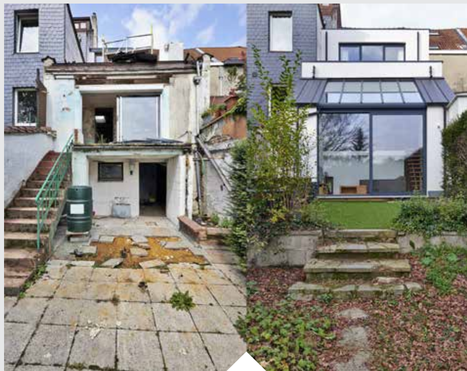
RÉNOVATION EXTÉRIEURE - INTÉRIEURE
